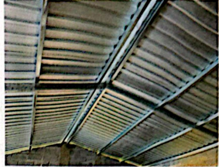
Foto 2: Instalación de estructura de techo
