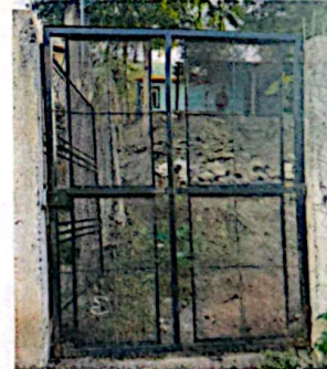
Foto 6: Mantenimiento a portón
