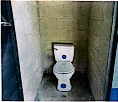
Foto 3: Mejoramiento de servicio sanitario
