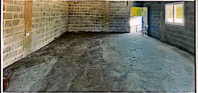
Foto 4: Mejoramiento de piso
