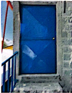
Foto 5: Instalación de puerta
