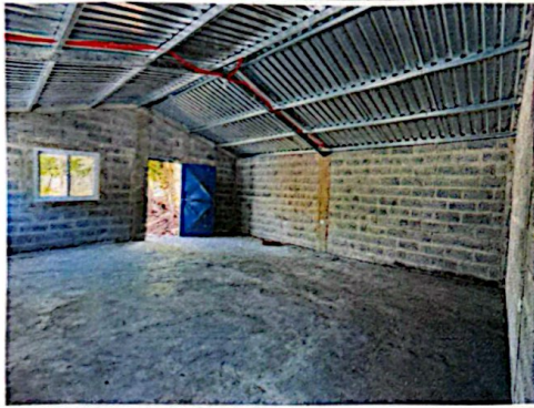
Foto 3: Mejoramiento de cubierta de lámina
