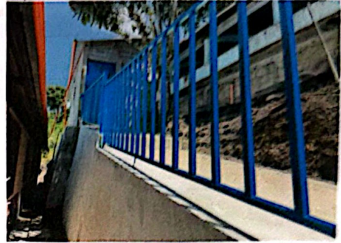
Foto 2: instalación de baranda
