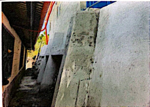
Foto 5: Mantenimiento de muro de contención
