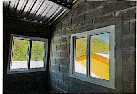
Foto 4: Instalación de ventanas
